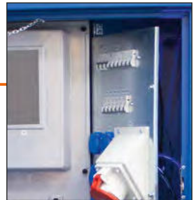
schwenkbare Montageplatte mit Wegbegrenzung
